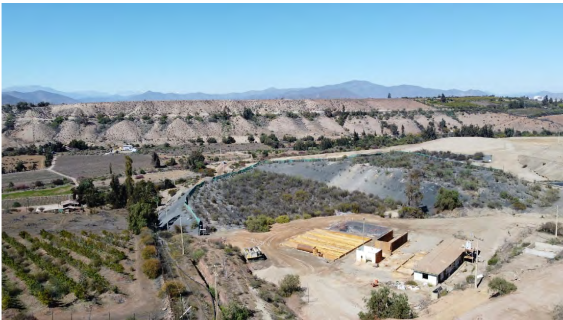
Figura N° 1. Depósito de relaves ubicado en la Comuna de Ovalle
